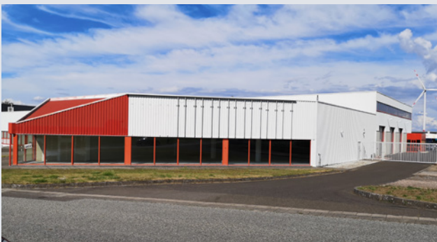
■ In den angrenzenden Gebäudeteilen sollen die Arbeitsbereiche Konfektionierung II und Technik Montage ihre neue Heimat finden.
